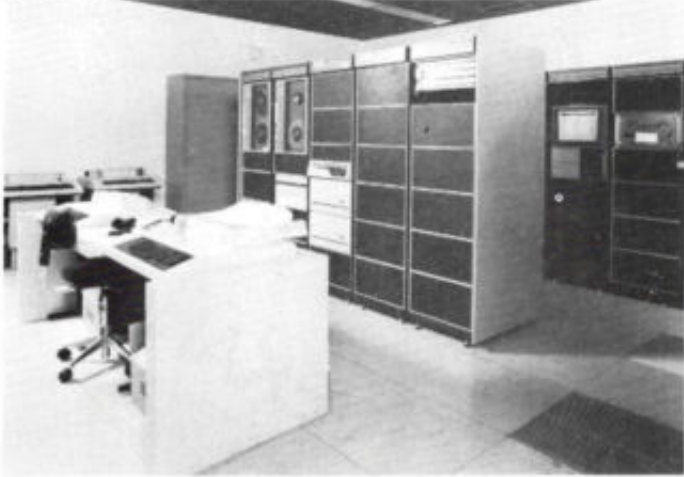
Computersysteem van het Controle en Informatie Centrum van Rijkswaterstaat in Hoek van Holland.
